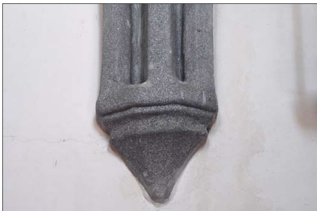
Obr. 2: Kostelec nad Vltavou, kostel Narození Panny Marie, severní klebební konzola na přechodu mezi obdélným polem chóru a polygonálním presbyteriem.
