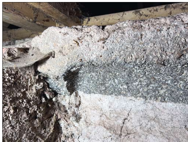
Obr. 5: Kostelec nad Vltavou, kostel Narození Panny Marie, kout mezi severní zdí lodi a západní zdí severního ramene transeptu. Detail zalomení kamenné fabionové římsy z koruny zdiva lodi k severu.
