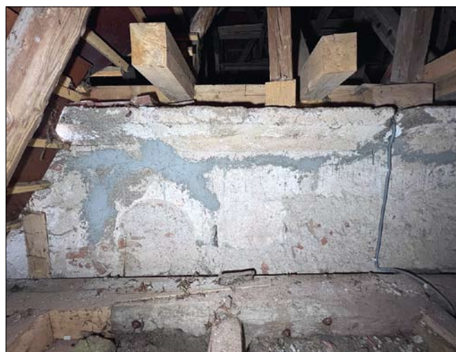
Obr. 4: Kostelec nad Vltavou, kostel Narození Panny Marie, líc jižní obvodové zdi lodi, krytý valbovou střechou jižního přístavku a jižního ramene transeptu. V levé (západní) části zřetelný půlkruhový záklenek s vápenými nátěry ve špaletě. Vpravo od něj jeden z druhotně (?) užitých kamenných kvádrů.
