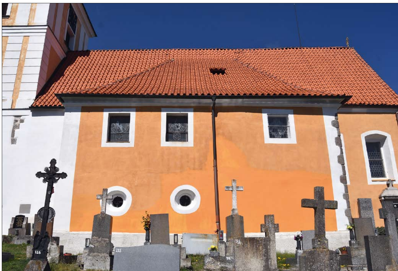
Obr. 6: Kostelec nad Vltavou, kostel Narození Panny Marie, jižní fasáda s blokem patrové tribunové přístavby (vlevo; v přízemí se starší kaplí) a průčelím jižního ramene transeptu. Jihozápadní nároží ramene transeptu je skryté ve hmotě přístavby a nachází se zhruba v místě okapové roury.
